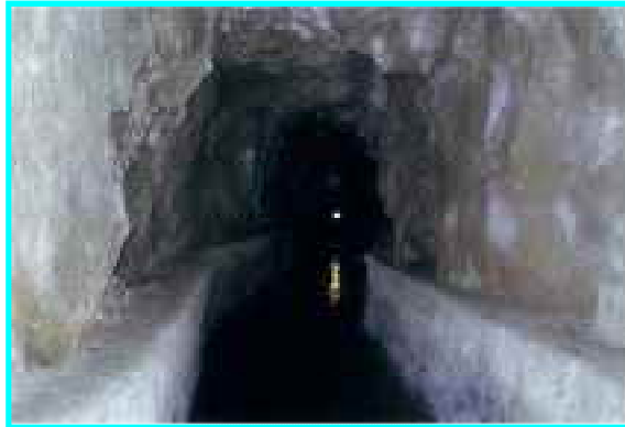
『水路隧道の内部を確認』
