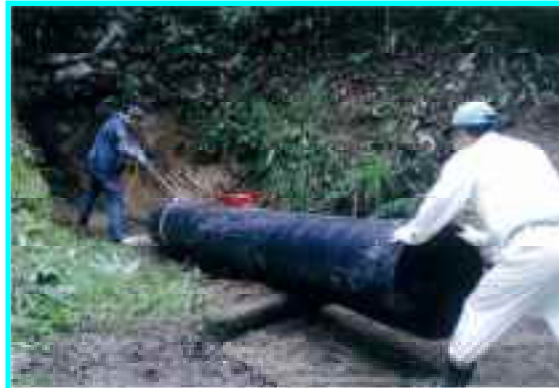
『塩ビパイプを水路隧道入口へ準備』
