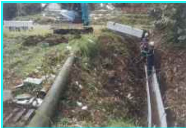
『今後の災害に備え土水路に製品を布設』
