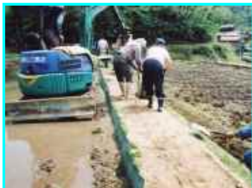
『畦畔、法面の補修』
