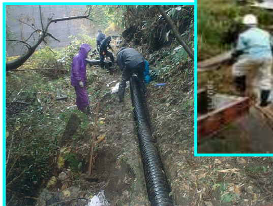
『山際の水路にパイプを敷設』
